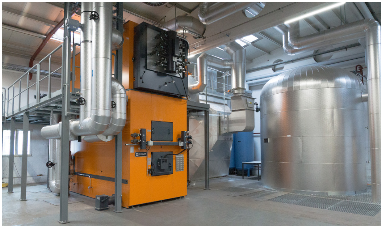
Schmid – sistema di combustione a griglia mobile UTSR-1600 visio
